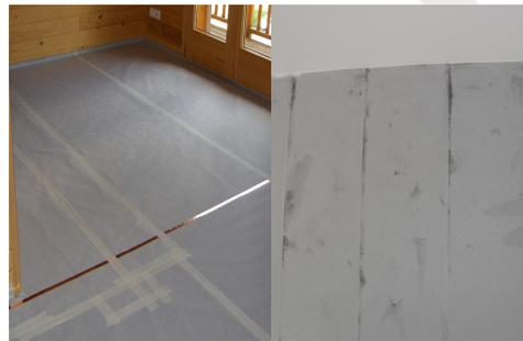
Le revêtement mural EMV est utilisé en une couche pour bloquer les champs électriques basses fréquences (BF). Appliqué en deux couches, il absorbe les ondes hautes fréquences (HF), ce qui lui confère un atout unique lors du blindage d'une pièce : les résidus liés à des fuites dans le blindage principal des autres murs sous forme de réflexions multiples d'ondes HF sont ainsi évités.
